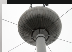
VODOJEMY / ZÁSOBNÍKY VODY
